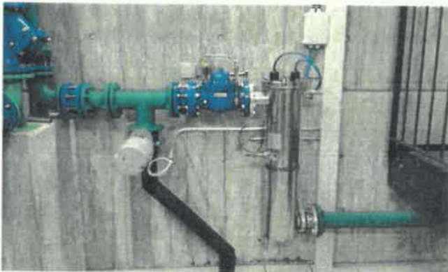
Collo di cigno per la regolazione della riserva incendio nel serbatoio Roncaccio
