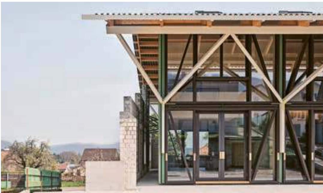
Fassadenansicht und Durchgang zwischen alten und neuen Mauern
