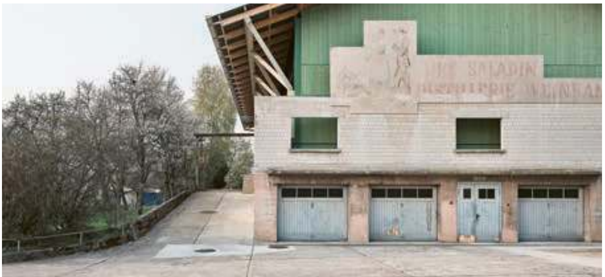
Strassenfassade mit dem alten Wandbild
