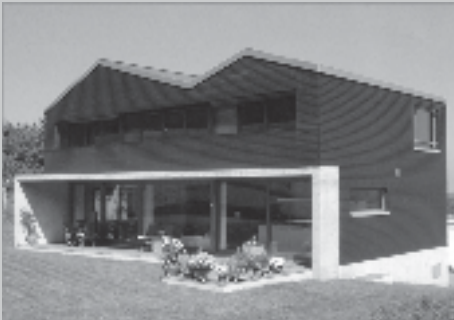
EFH, Hollenweg 2, Metzerlen Bauherrschaft: K. und L. Begglinger, Metzerlen Architekten: Beck + Oser, Basel
