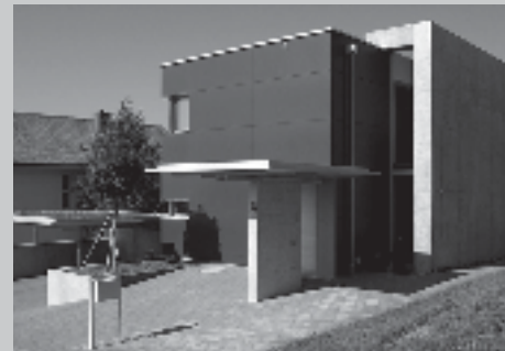
EFH Strahm-Party, Neuriedweg 4, Bellach Bauherrschaft: K + J. Strahm-Party, Bellach Architekten: G&Z Architektur, Max Gygax und Thomas Zwygart, Solothurn
