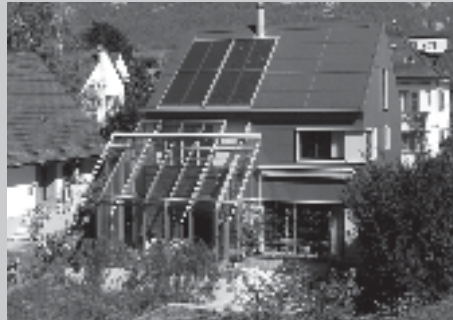
EFH Gygax, Sanierung, Bourbakistrasse 34, Solothurn ; Bauherrschaft: M. und S. Gygax-Jenni, Solothurn Architekten: G&Z Architektur, Max Gygax und Thomas Zwygart, Solothurn
