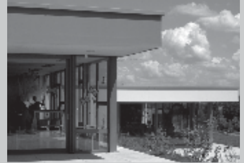
Doppelkindergarten, Friedhofstrasse, Lohn-Ammannsegg Bauherrschaft: Einwohnergemeinde Lohn- Ammannsegg Architekten: Felber + Szélpal, Solothurn
