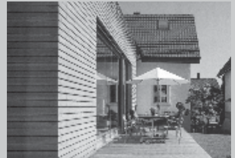
Um- und Neubau Haus Schröder-Schürmann Untergrundstrasse 18, Olten Bauherrschaft: M. Schröder Schürmann und R. Schürmann, Olten Architekten: Werk1 Architekten + Planer, Olten
