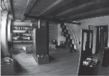
Erneuerung Mühle, Mittelgäustrasse 2, Rickenbach SO Bauherrschaft: Markus Capirone, Rickenbach SO Architekt: Anton Scheidegger, Riken AG
