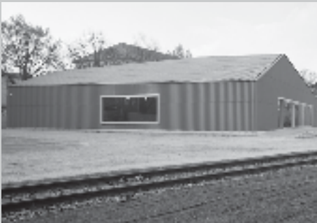
Personalrestaurant SBB Tannwald Industriestrasse 55, Olten Bauherrschaft: SBB, Luzern Architekten: Lussi + Halter Architekten Luzern
