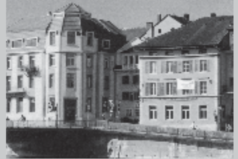
Altstadtgebäude, Stalden 1, Solothurn Bauherrschaft: STWE U.+ R. Mühle, O. Ruprecht, E.+ B. Rutishauser, Dr. J. Thellmann Architekten: Arnet-Architektur, Lotti Arnet, Solothurn
