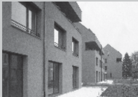
Mehrfamilienhäuser, Wohnüberbauung Kaiser, Steinmattstr. 27, Derendingen Bauherrschaft: Ernst und Robert Kaiser, Basel Architekten: Berrel Architekten, Basel
