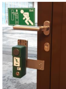
Exit Controller Eingebaut, Dauerfreigabe
