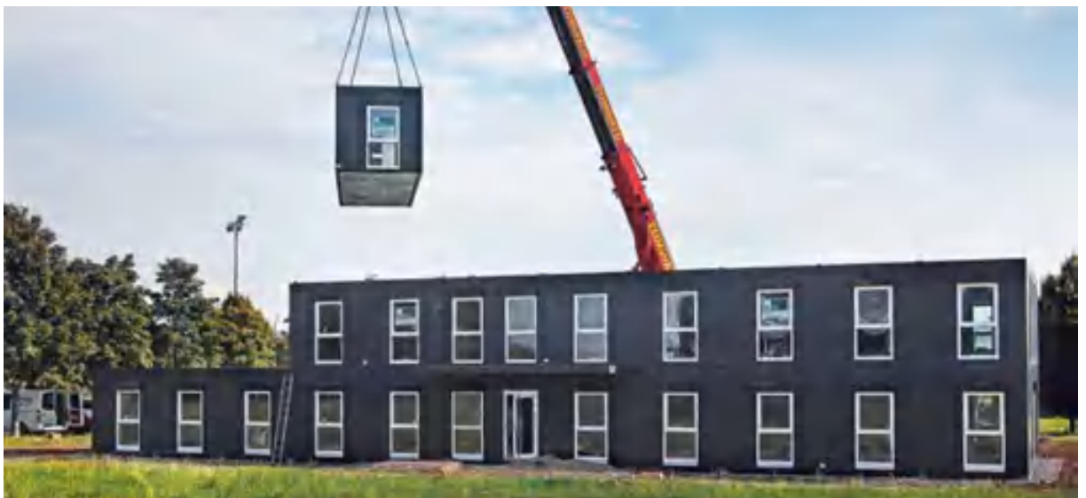
Versetzen der Container
