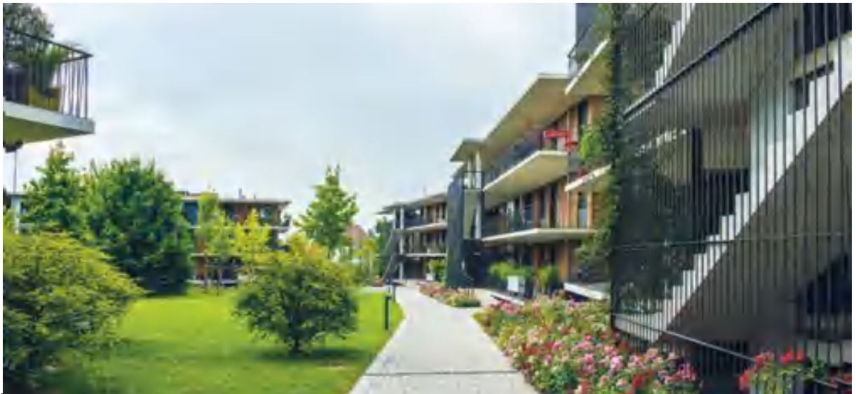
Hofdurchgang von Norden nach Süden
