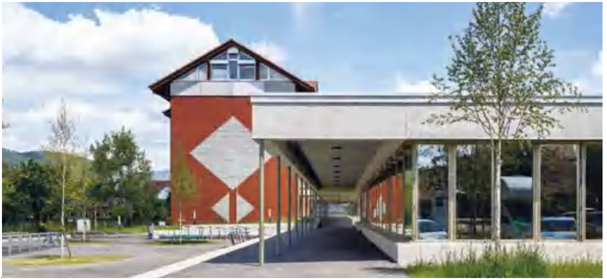
Fassade mit Bestand
