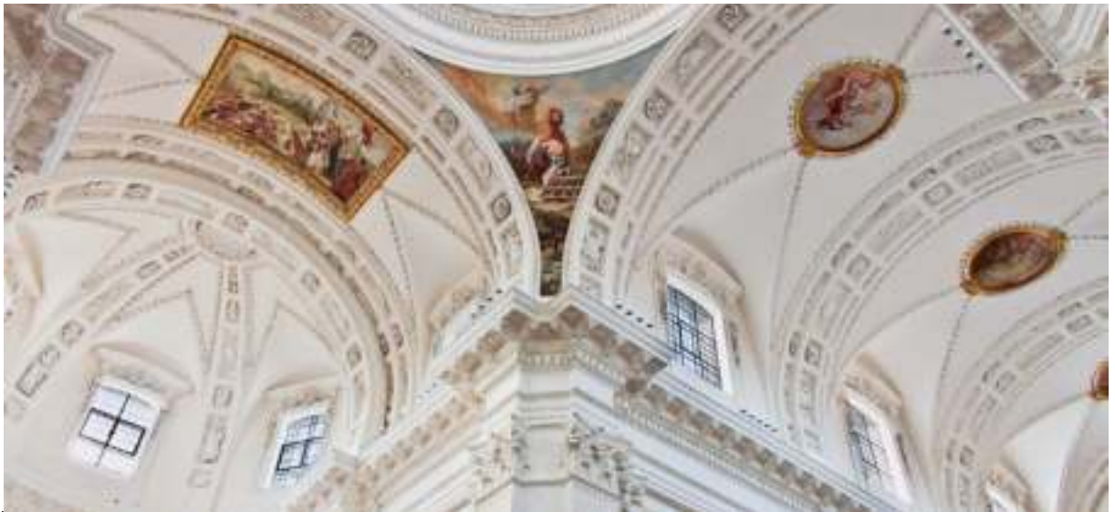
Innenraum mit neuer Beleuchtung
