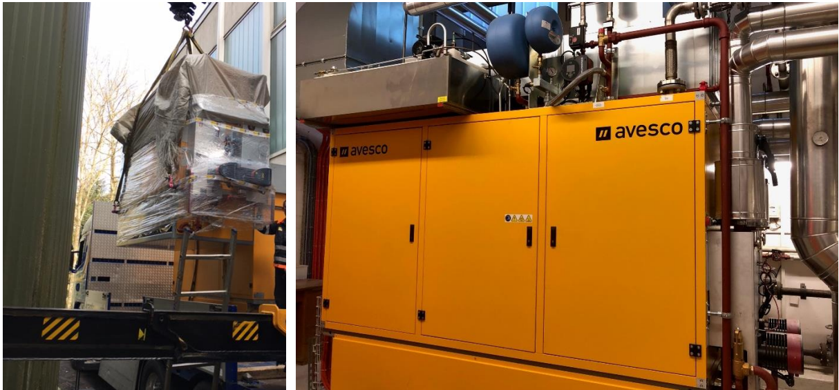
Abbildung 8, Anlieferung des neuen BHKW und neues BHKW im Einsatz, Quelle: ZSA Pfannenstiel
