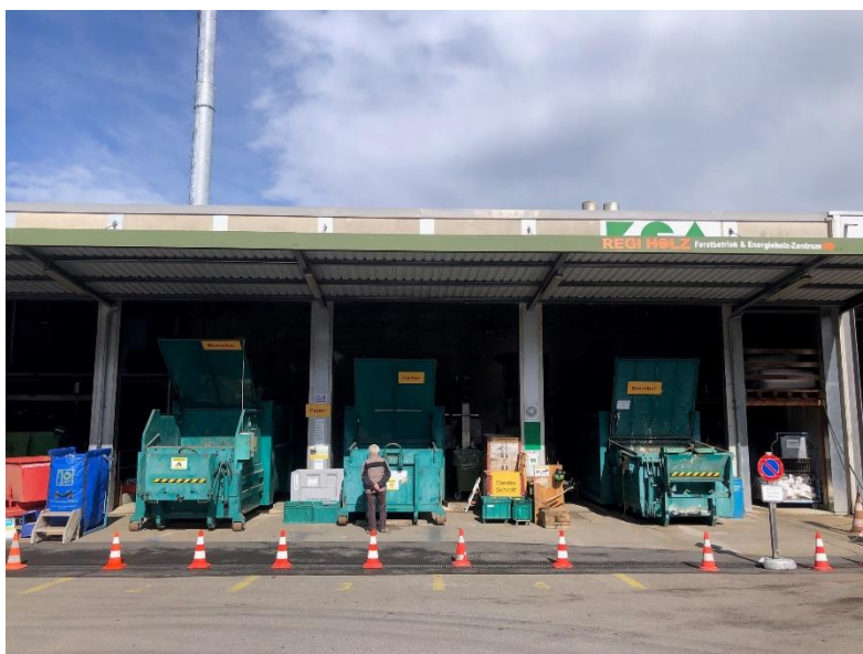
Abbildung 9, Überdachte Abfallsammelstelle, Quelle: ZSA Pfannenstiel
