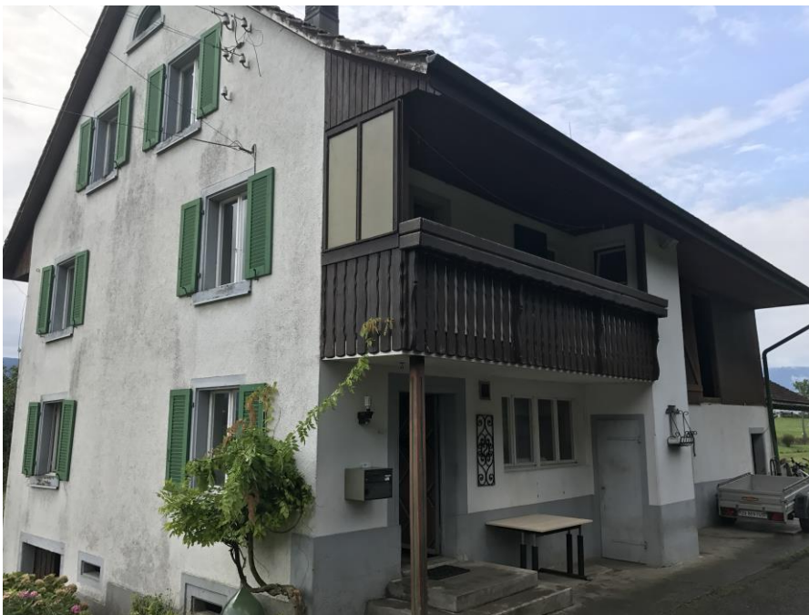
Abbildung 3: Hauptgebäude mit Wohnteil
