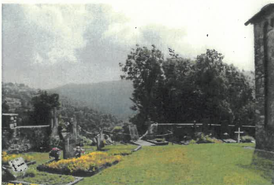
Figura 4: Situazione a monte del muro ceduto
