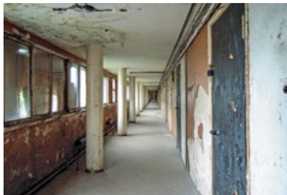
Erschliessungsgang im Narkomfin-Gebäude.
