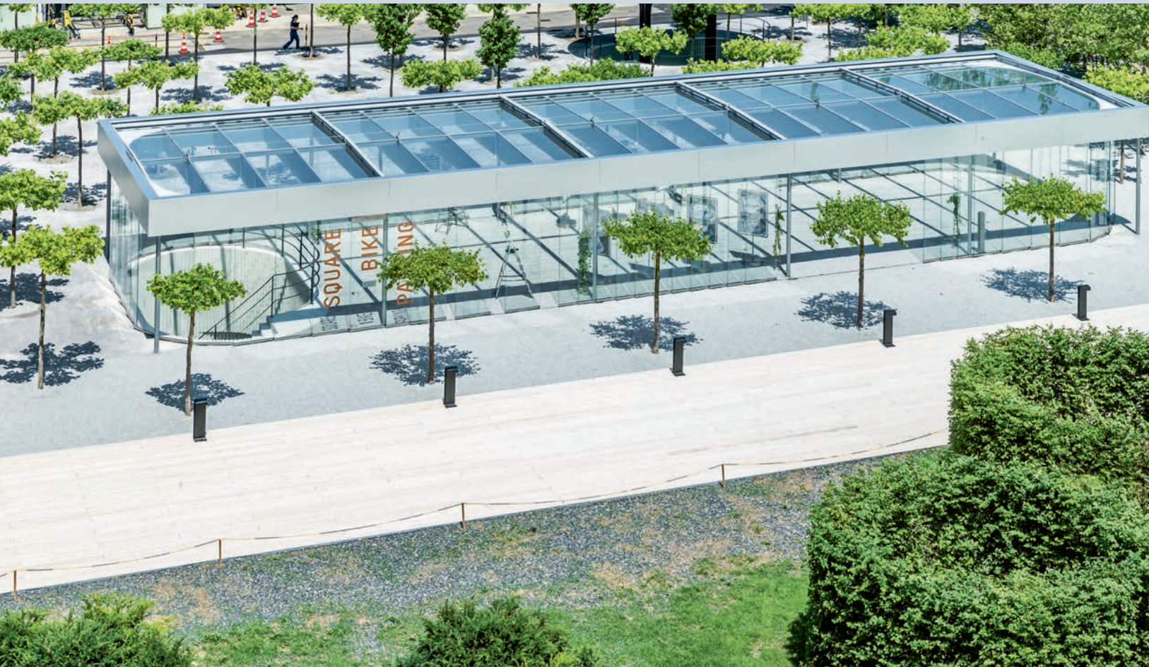
Der vollverglaste Pavillon steht auf schlanken, eleganten Stützen. Le pavillon entièrement vitré repose sur d'élégants supports élancés.
