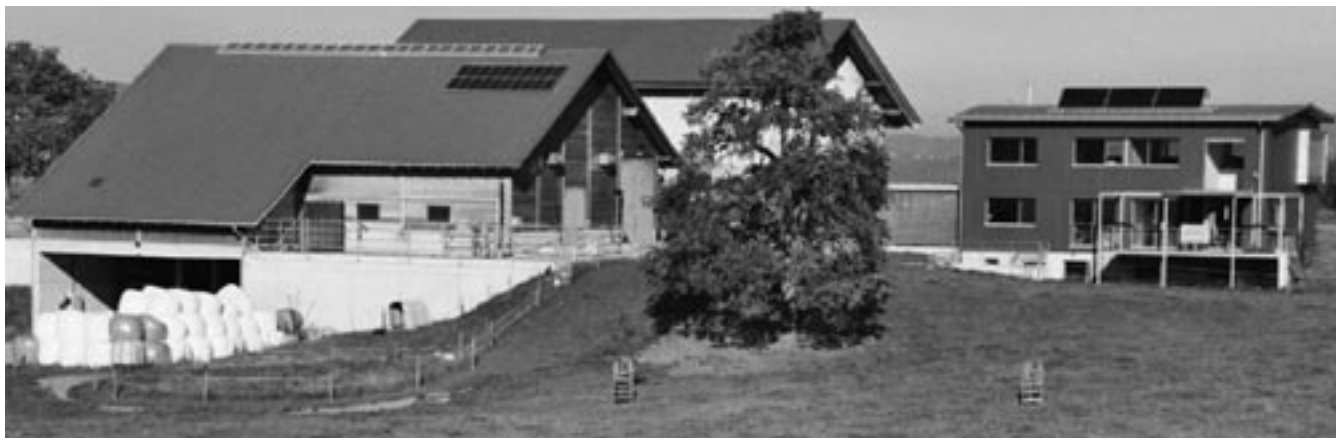
Das Minergiehaus von Beny Koch und Esther Reinert, wo der Oekologiegedanke konsequent umgesetzt wird.
