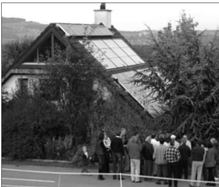
Am 23-jährigen Einfamilienhaus von Walter Haus konnte man sehen, dass es auch da sinnvoll ist, erneuerbare Energie zu nutzen.
