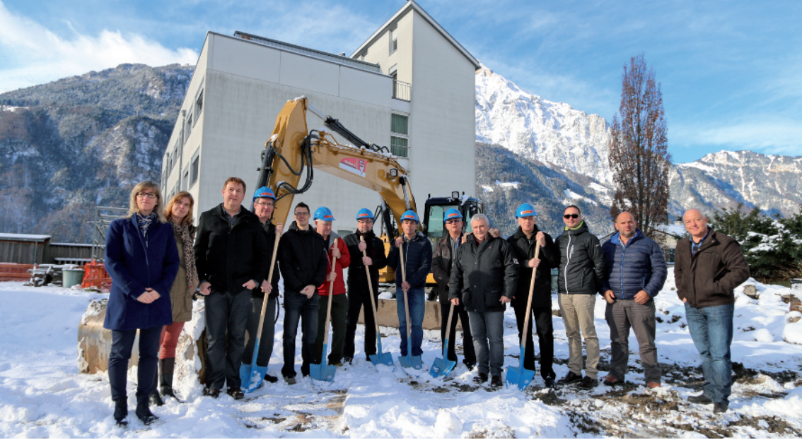
15. Januar 2016: Offizieller Spatenstich für den Erweiterungsbau Phönix Uri.
