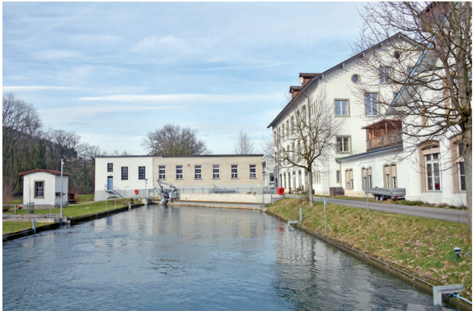
Bild 9: Oberwasserkanal mit KW und Fabrikgebäuden heute
