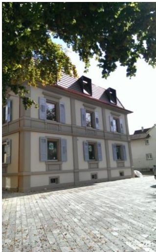
Villa, Oristalstrasse 13, Liestal
