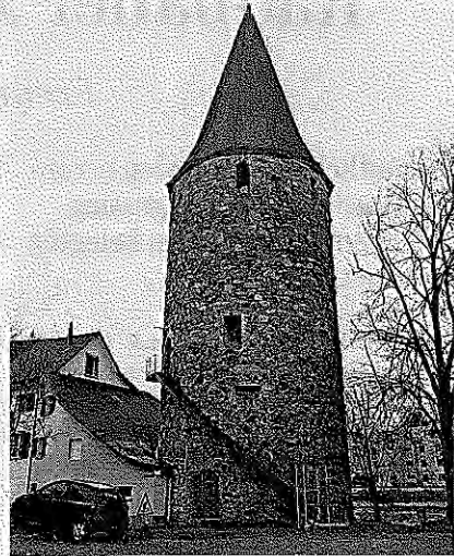
Der Hexenturm wird im Innern renoviert.
