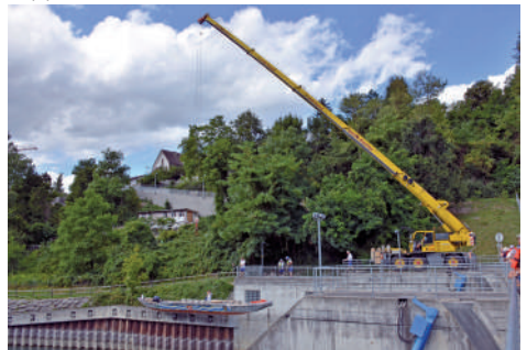
Bild 16: Übersetzen mit Pneukran nach Unterstrom
