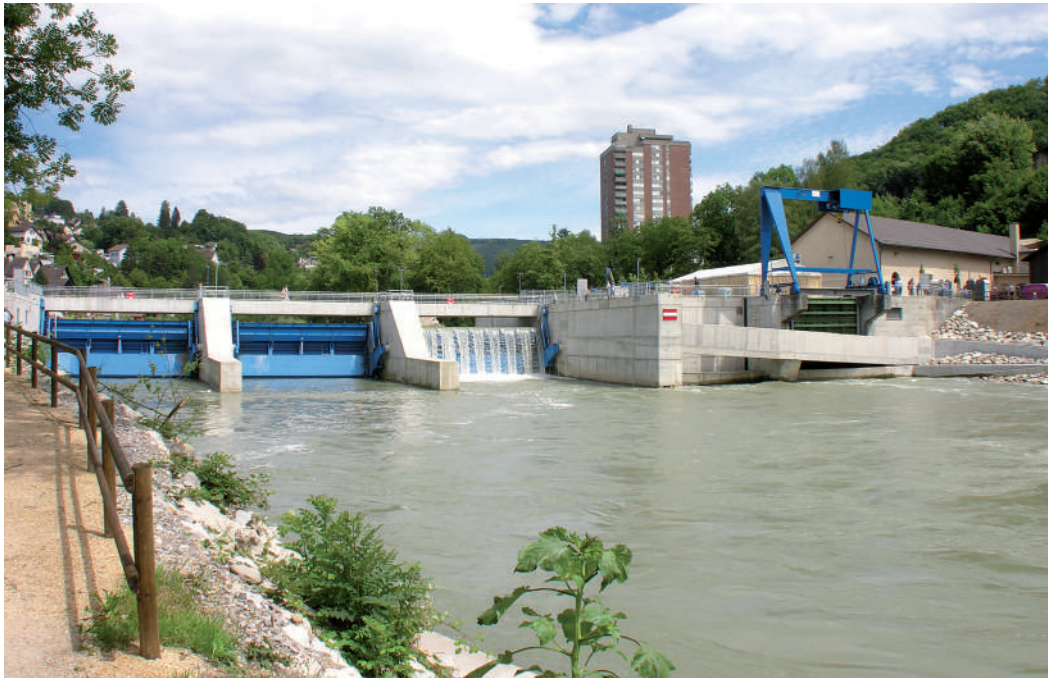
Bild 12: Neues Wehr mit neuem und alten Maschinenhaus im Jahr 2007
