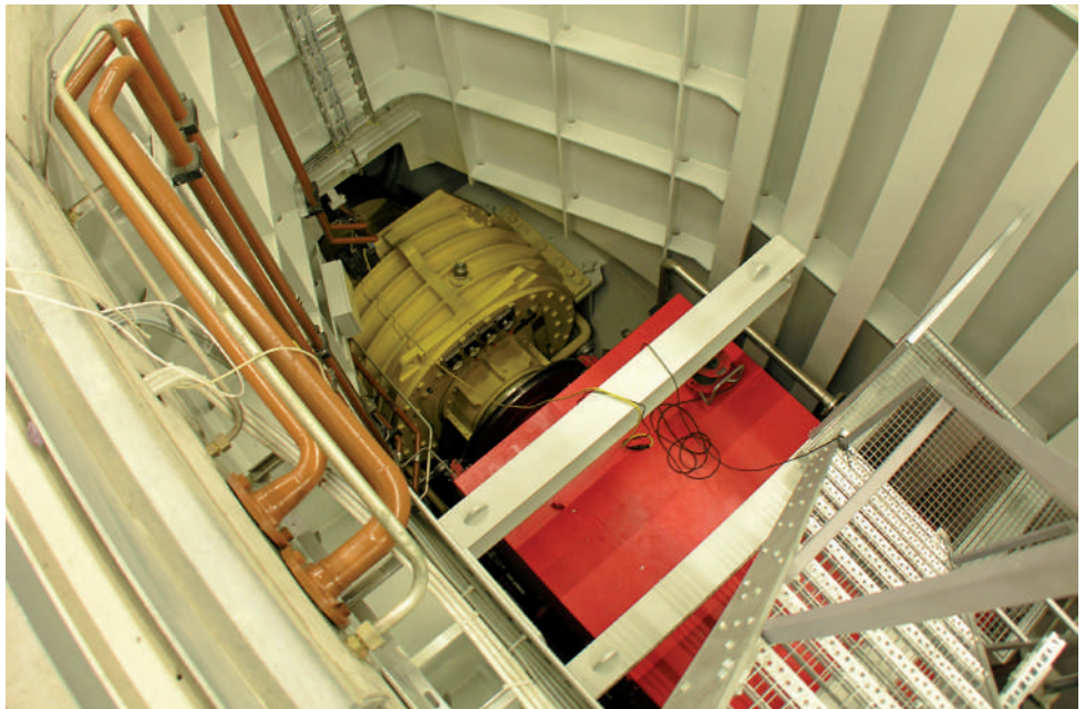
Bild 11: Kaplan-Rohrturbine 2006
