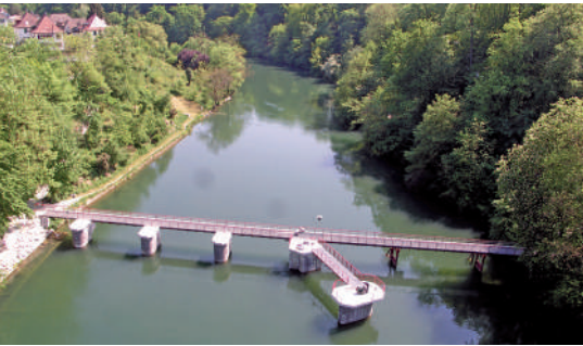
Bild 13: Kappisee Fussgängerbereich mit alten Wehrfeilern Mai 2007
