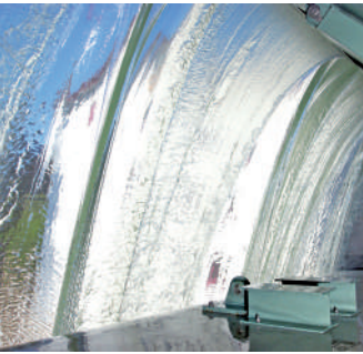
Bild 11: Überlaufklappe Wehrfeld
