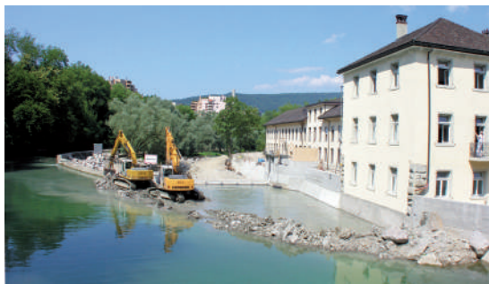
Bild 8: Sanierungsarbeiten am unteren Wettingerweh Damsau 2006
