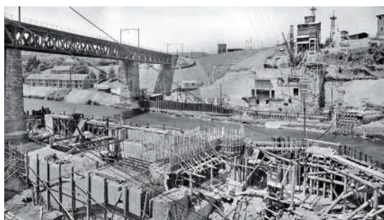
Bild 5+6: KW Wettingen im Bau März+Juni 1931
