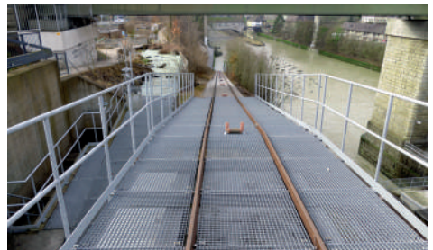
Bild 20: Kahnrampe Blickrichtung Unterstrom
