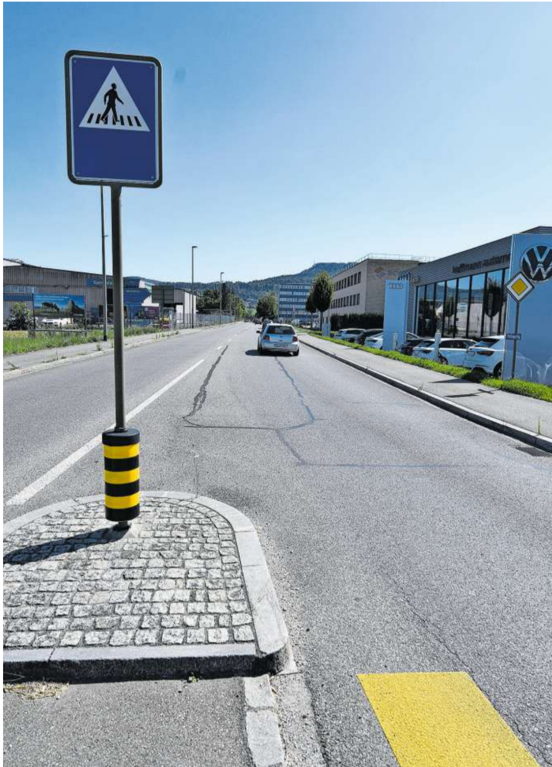
Am Pfeffingerring in Aesch hat der Kanton bereits lärmarmen Belag eingebaut. Bild: J. Junkov (11. Juli 2022)
