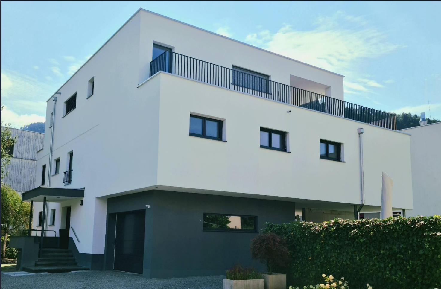
Aus einem Einfamilienhaus wurde, durch einen teilweisen Abbruch und eine Aufstockung auf das bestehende Obergeschoß, ein Mehrgenerationenhaus. Der zweigeschossige Bestandsbereich wird weiterhin als elterliche Wohnung genutzt, während das zugebaute Teil des ersten Obergeschoßes und das gesamte Dachgeschoss eine komplett neue Wohneinheit bilden. Durch den Rücksprung des Dachgeschosses entstand eine großzügige, umlaufende Terrasse.
