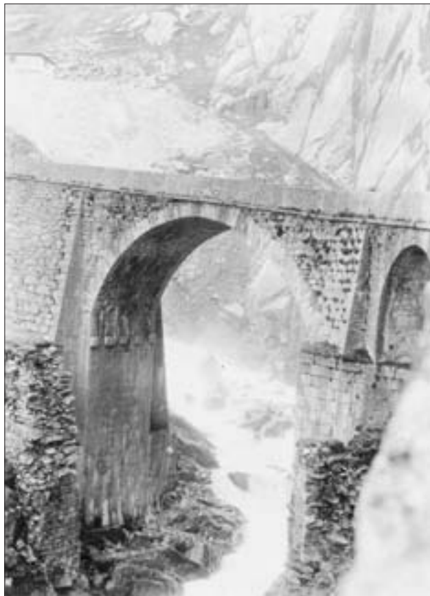
Nahaufnahme der Teufelsbrücke, die die Bauweise gut erkennen lässt. FOTOS: ZVG
