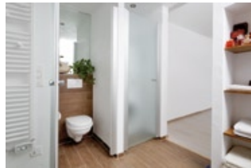
Fertigstellung Sanitär und Elektriker haben die Armaturen und Elektrik angeschlossen. Der Wäscheturm ist aufgebaut, die Duschtüren wurden montiert und die Silikonfugen angebracht.
