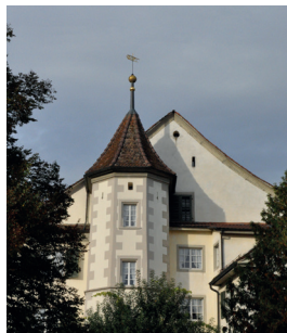
„Schlössliturm“ - der Schneckenturm befindet sich an der Südseite des Schlössli
