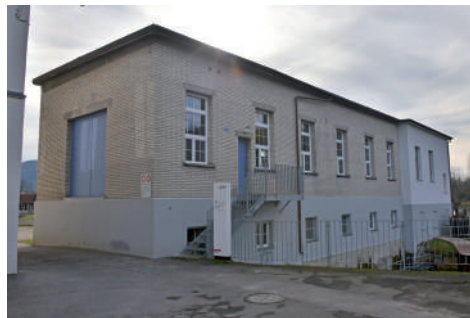
Bild 17: Kraftwerk Stroppele heute
