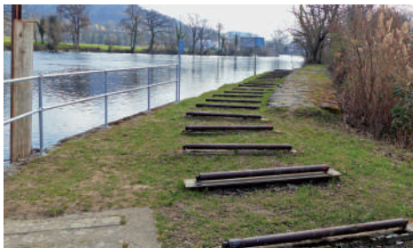
Bild 32: Rollenbahn Stropfel Oberwasser
