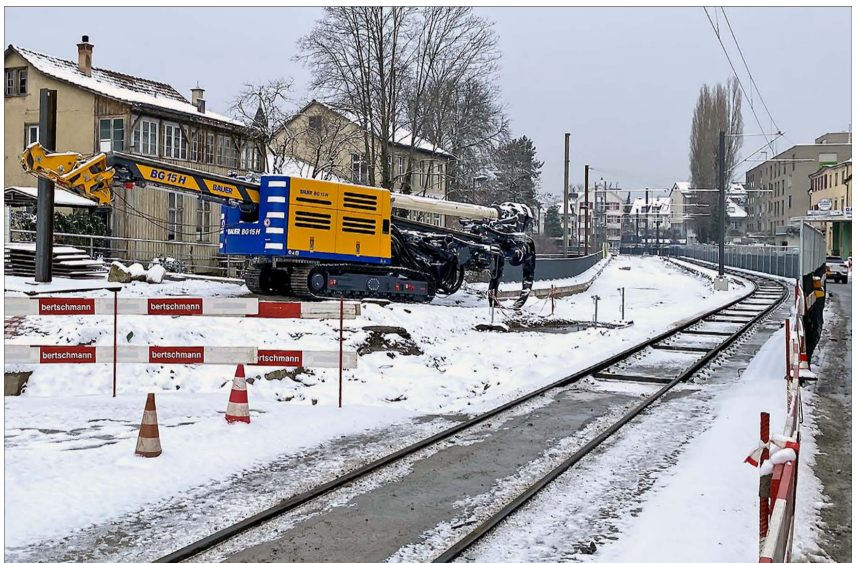
Am 16. Januar 2024 starten die Hauptarbeiten zur neuen Gleistragplatte am Birsig, dem eigentlichen Herzstück des Doppelspurausbaus. Dazu werden von der Trambaltestelle Binningen Schloss bis zur Brückenstrasse hinter der Bachmauer 42 sogenannte Kleinbohrpfähle gesetzt, worauf die Gleistragplatte zu liegen kommt. Foto: ns
