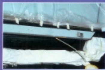
Zuerst wird die Sonde so weit wie möglich in den Hohlraum eingeführt.
