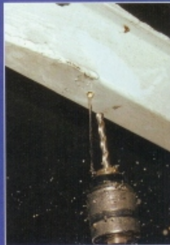
...zeigt dieses Bild: Rund ein halber Liter Wasser hat uns nach dem Bohren entgegen
