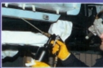
Dann betätigt man die Pistole und zieht den Schlauch langsam wieder heraus.
