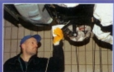
Der Hohlraum bestimmt die Länge des Schlauchs. Oft wird das Fett von zwei Seiten eingebracht.
