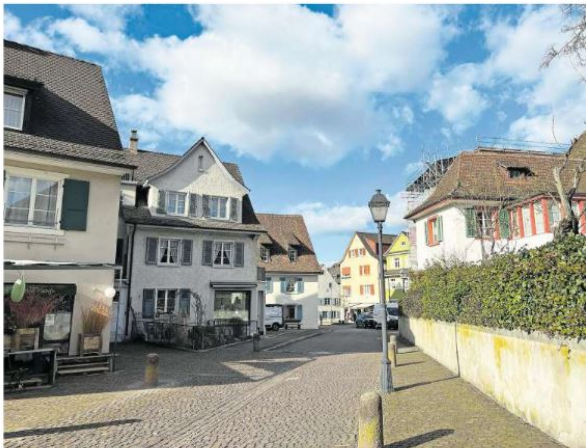
Historischer Dorfkern: 60 private Liegenschaften sollen unter Schutz gestellt werden.
