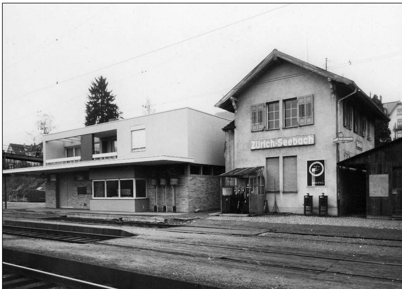
Um 1960 – Bahnhof Zürich-Seebach. Neues Stationsgebäude, rechts der zum Abbruch bereite alte Bahnhof. (BAZ).
