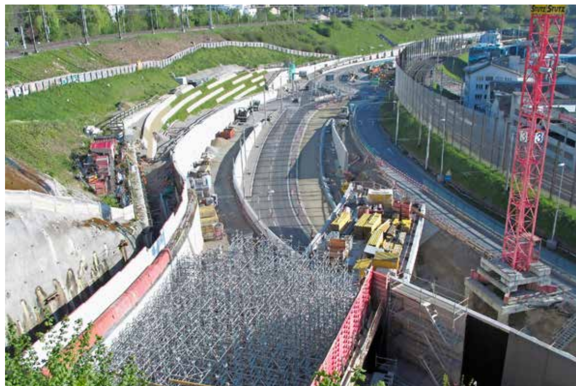
«Die zukünftige Strassenführung in Richtung Schaffhausen ist deutlich sichtbar geworden», schreibt Leser Werner Müller zu dem Bild, das er bei Schloss Charlottenfels geknipst hat. «Auch ist deutlich das Gerüst für die Überdachung der Tunnelausfahrt zu erkennen.» Bild: zvg
