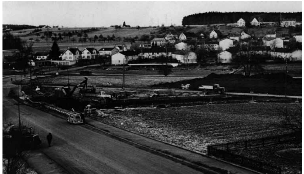
Auftakt zur zweiten Bauphase der Baugenossenschaft Schönau an der Köschenrütli-/Schwellistrasse ...
