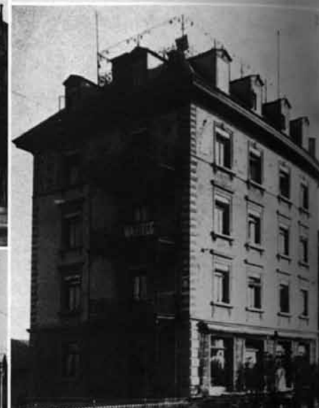
„Wartegg“, Schaffhauserstrasse 418, um 1900
