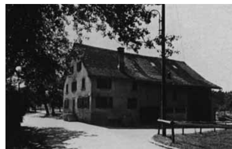
Die sogenannte „Zehntenscheune“
