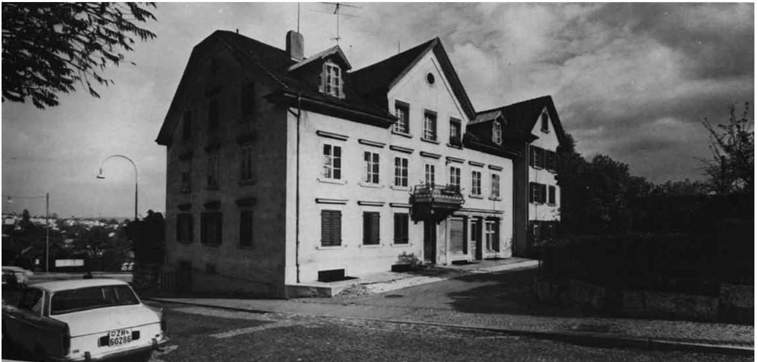
Im Vordergrund das bis zur Unkenntlichkeit umgebaute ehemalige Bauernhaus Buhnrain 3 im Jahre 1970, kurz vor dem Abbruch.
