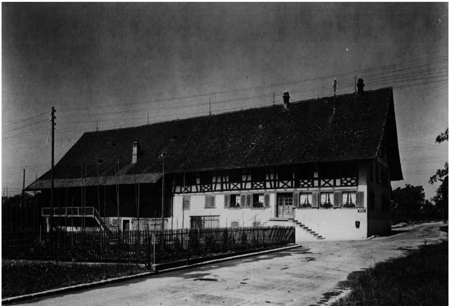
Köschenrütistrasse 185: Das „Unter Haus“.
