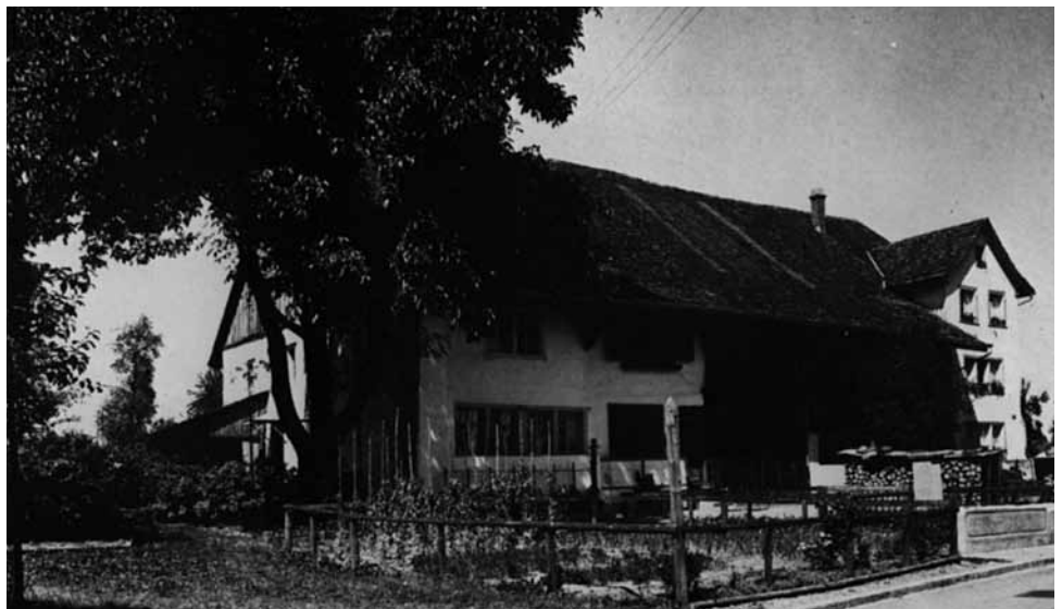
Ausserdorfstrasse 10, 8 und 6 (v.l.n.r.) mit Brunnen und Bauerngarten
