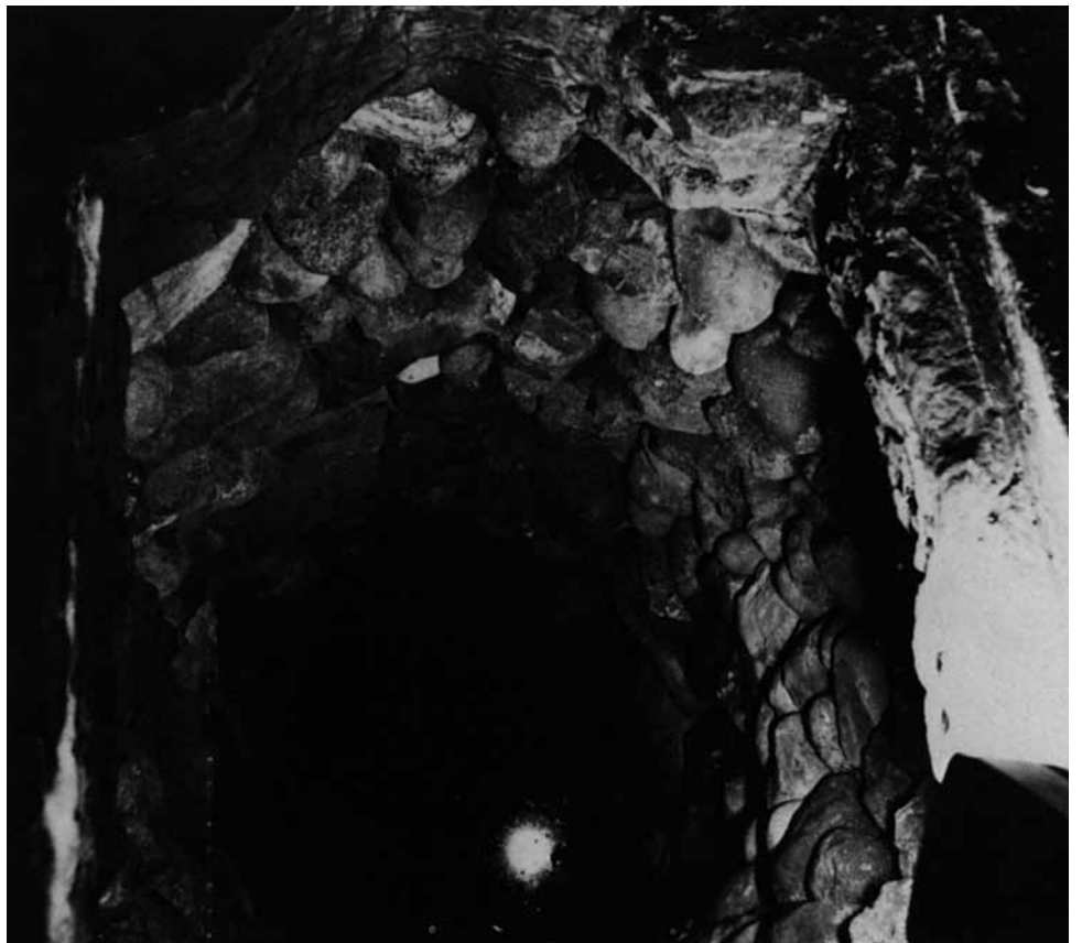
Ehemaliger Sodbrunnen an der Hürststrasse 102
