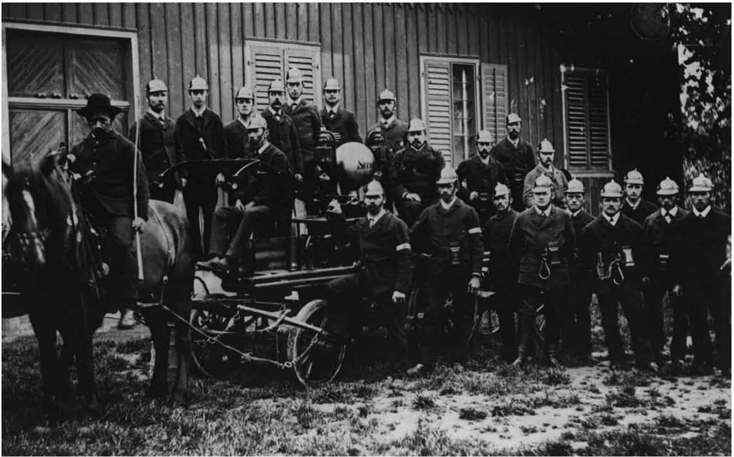
Die Seebacher Gemeindefeuerwehr im Jahre 1895 vor dem Depot Seebacherstrasse
