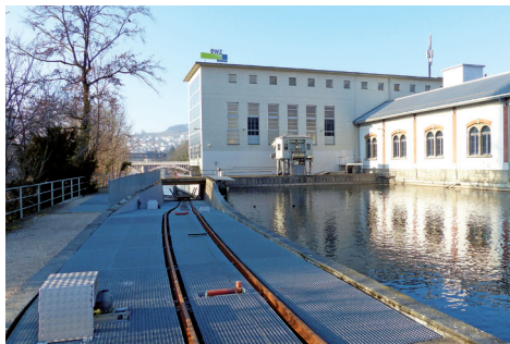
Bild 6 : Kahnrampe mit integrierter Fischtreppe
