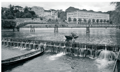
Bild 8 : Nadelwehr beim Platzspitz
