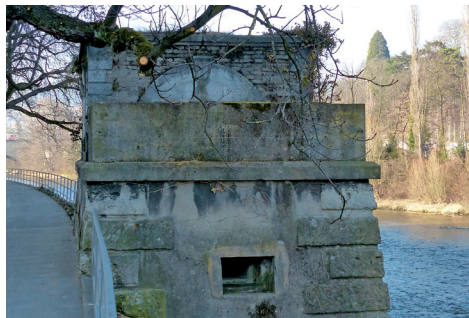
Bild 3: Ehem. Sockel für die Drahtseiltransmission
