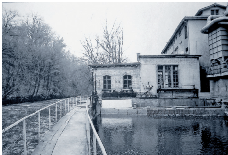
Bild 8: Turbinenhaus KW Oederlin
