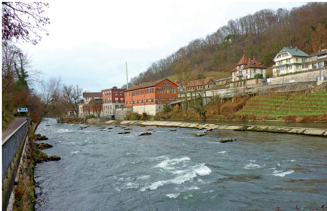
Bild 6: Areal Oederlin AG mit Oberwasserkanal und Streichwehr heute
