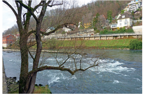
Bild 5: Limmat mit Oberwasserkanal und Streichwehr Oederlin AG
