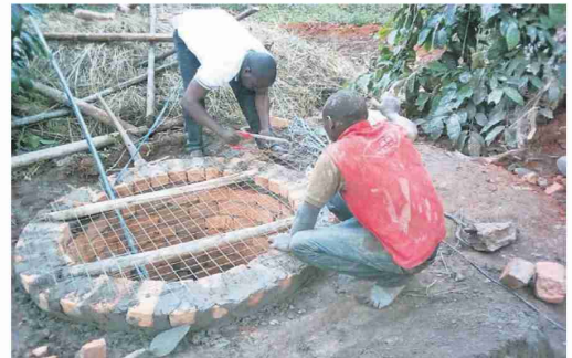
Mit einfachsten Hilfsmitteln wurde vor Ort ein Brunnen gebaut. Er ist wichtig, wenn hier später ein Waisenhaus stehen soll.
