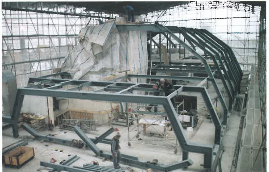
Die neue Dachkonstruktion
