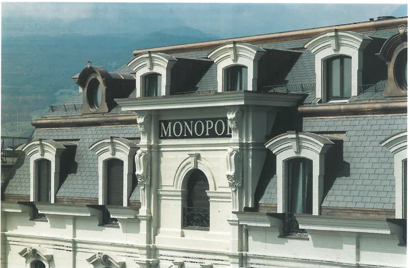
Die beiden neuen Obergeschosse
