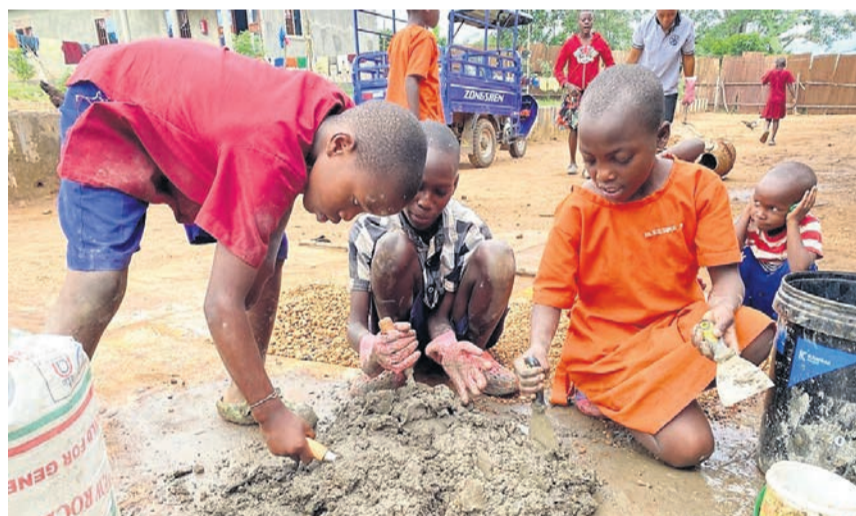
Beim neusten Bauprojekt packten auch die Kleinsten tatkräftig mit an.
