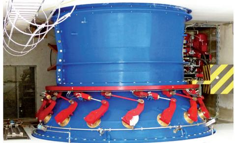
**Bild 14:** Leitapparat der Kegelrad-Rohrturbine im Kraftwerk Aue
