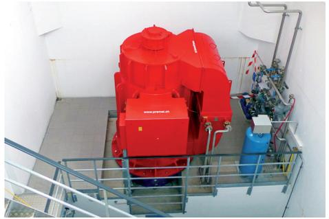
**Bild 13:** Generator der neuen Kegelrad-Rohrturbine im Kraftwerk Aue
