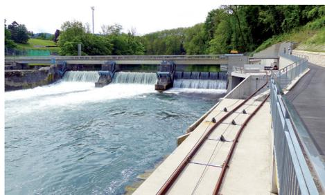
*Bild 16: Segmentwehr und neue Kahnrampe*
