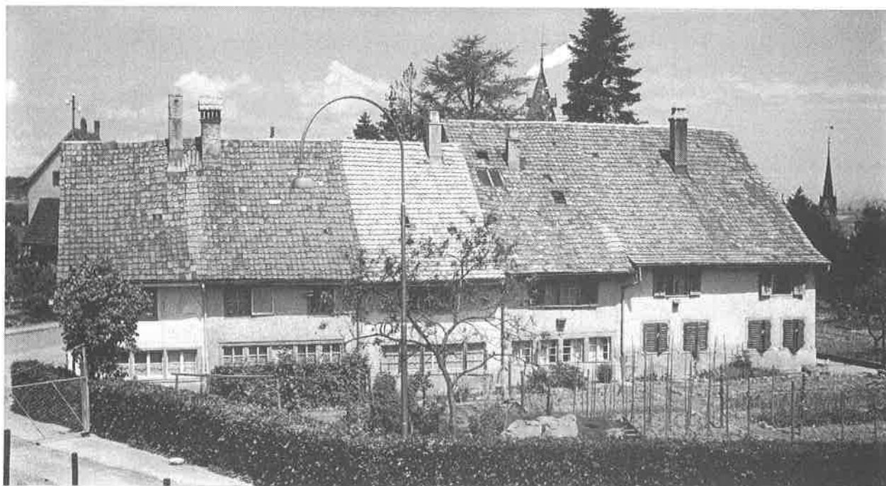
1957: Die alten Flarzhäuser auf der Buen (vor der Renovation).
