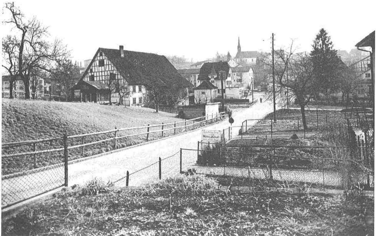
Blick auf das 1967 abgetragene Haus 'am Bach', heute Gemeinschaftszentrum. Aufnahme von 1957.
