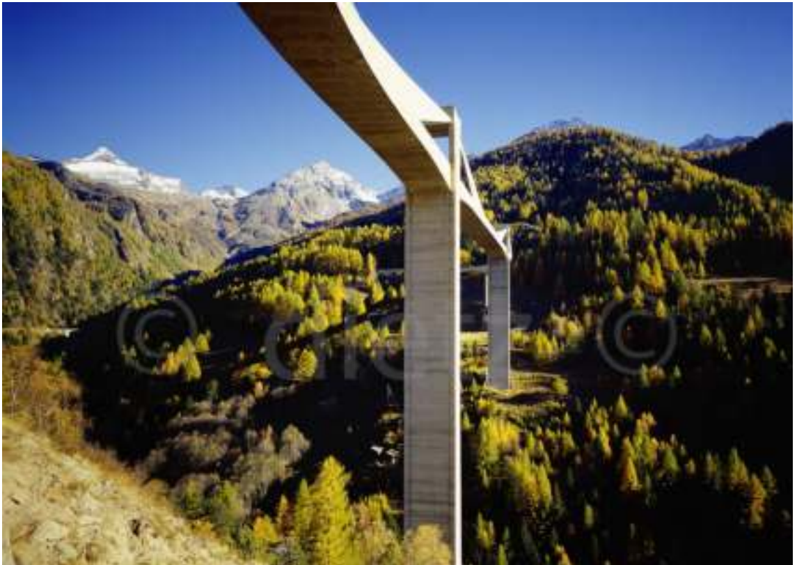
Simplonpass, Gantertalbrücke - VS
