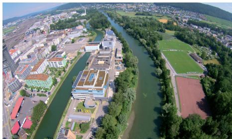
Bild 12: KW Dietikon mit Ober-, Unterwasserkanal und Limmat 2014
