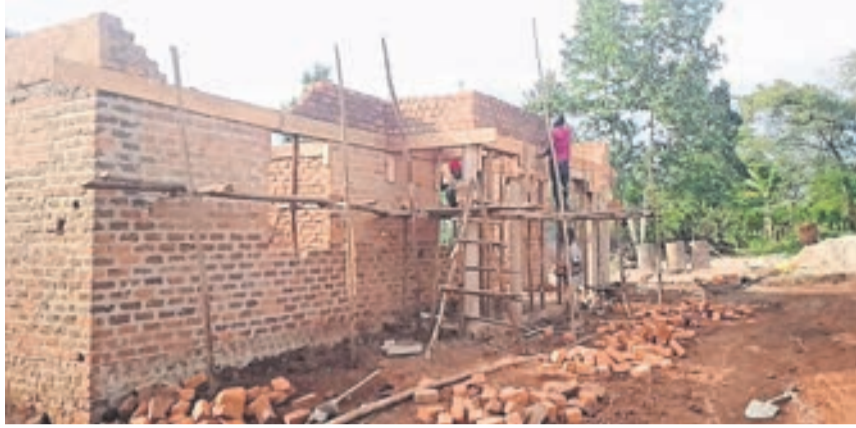
Der Baustart für das neue Waisenhaus in Kanyogoga, gut 70 Kilometer ausserhalb der Hauptstadt Kampala, hat schon Anfang März begonnen. Die Arbeiten kommen gut voran. In einer ersten Etappe sollen zwei provisorische Wohnhäuser für die Kinder und die Betreuer erstellt werden.
