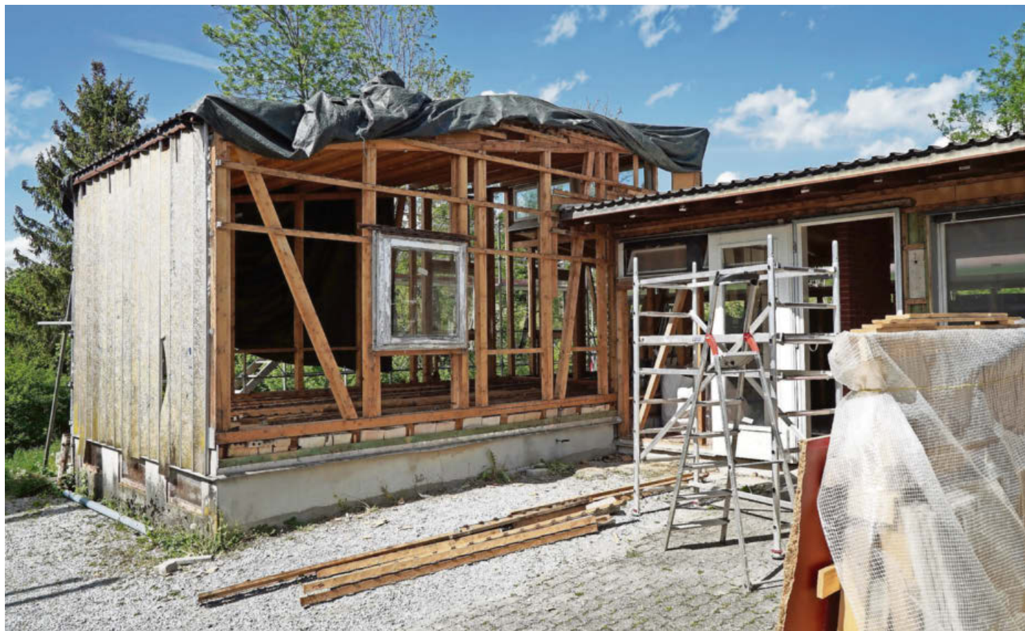
Kurz vor dem Abriss konnte der Saffa-Pavillon vor der Vernichtung gerettet werden. Foto: Sonja Flury
