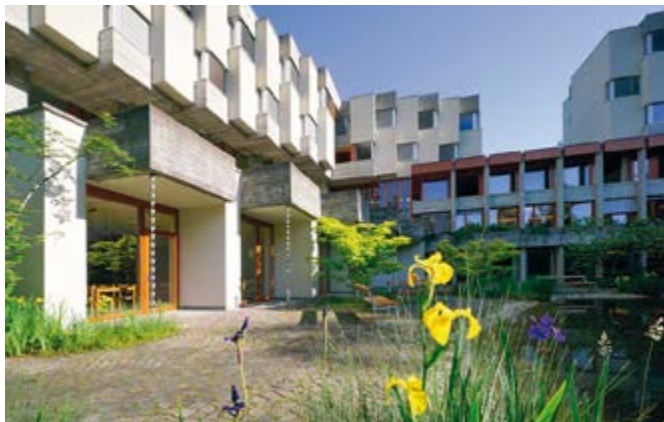
Das Haus vom Innenhof aus
