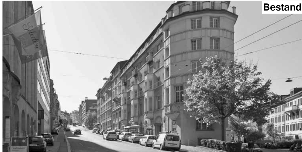
Teufener Strasse – Bestand
