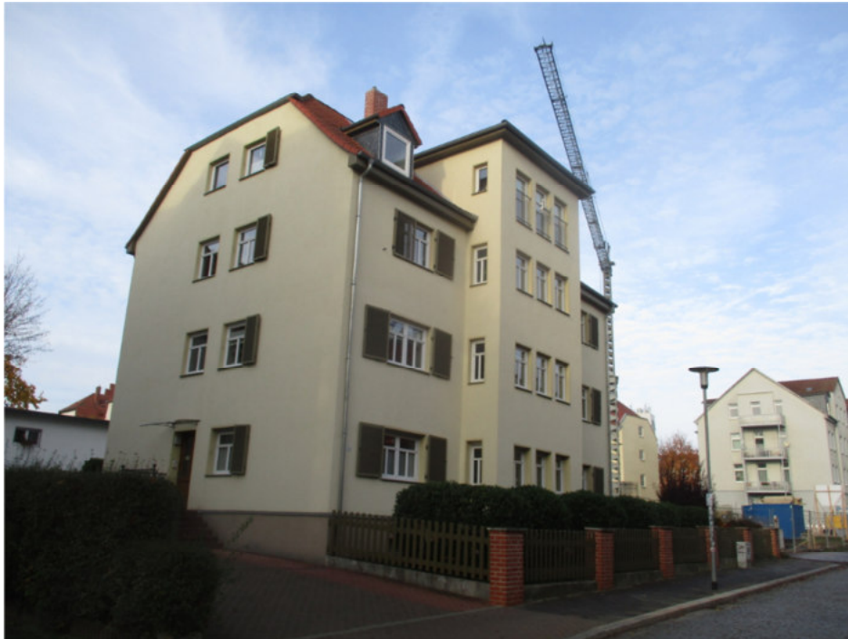
Die Liegenschaft Am Stadtpark 34 in Erfurt
