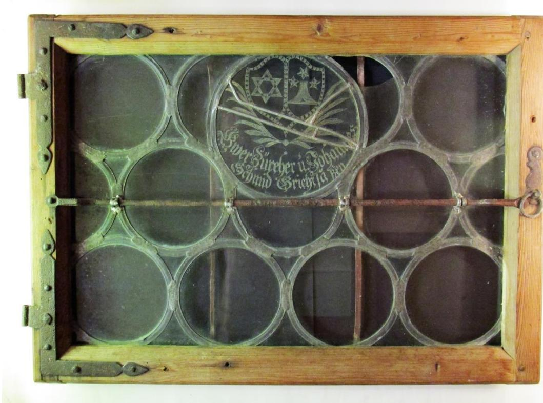
Die geritzte runde Scheibe oben in der Mitte liess erahnen, dass es sich um ein wahrscheinlich weitestgehend originales Fenster aus der Zeit um 1800 handelt. Einige leicht zu erkennende Reparaturarbeiten sind sicher neueren Datums.
