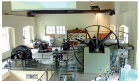
Bild 7: Maschinenraum mit Rohrturbine Jonval- und Francisturbinen mit Generatoren
