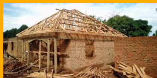
Bilder vom Bau der ersten zwei Gebäude
