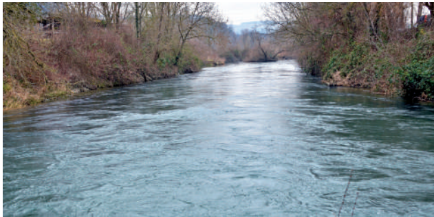
Bild 12: Unterwasserkanal des KW zur Aare
