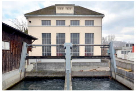
Bild 8: KW mit Oberwasserkanal und Einlaufrechen
