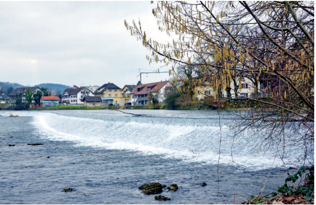
Bild 6: Streichwehr Vogelsang mit Oberwasserkanal
