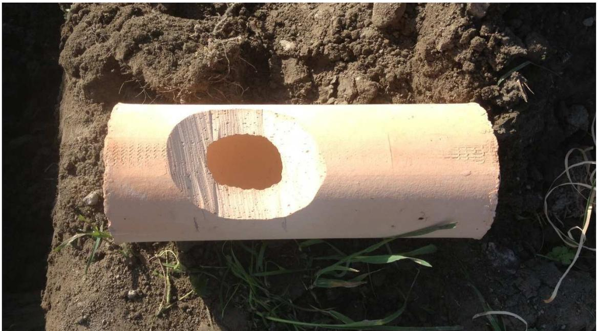
Im sandigen Boden werden die Sammel- und Saugerleitungen mit Holzwolle überdeckt, diese natürliche Filterschicht verringert das Eindringen von Sand in die Leitungen.
