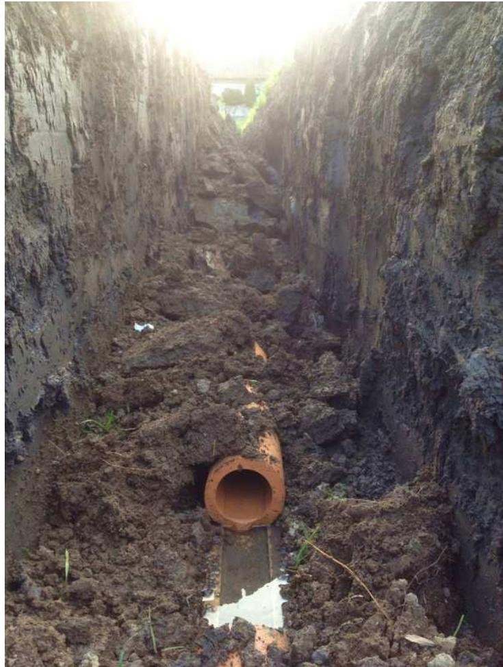
Für den Anschluss an die Sammelleitung werden die Tonrohre aufgefräst.
