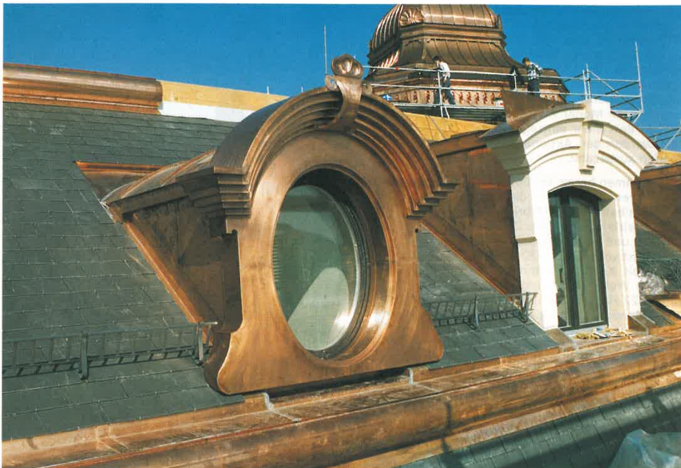
Die reich verzierten Frontpartien der Lukarnen und Ochsenaugen wurden in der Werkstatt vorgefertigt und als Attrappe vorgehängt.
