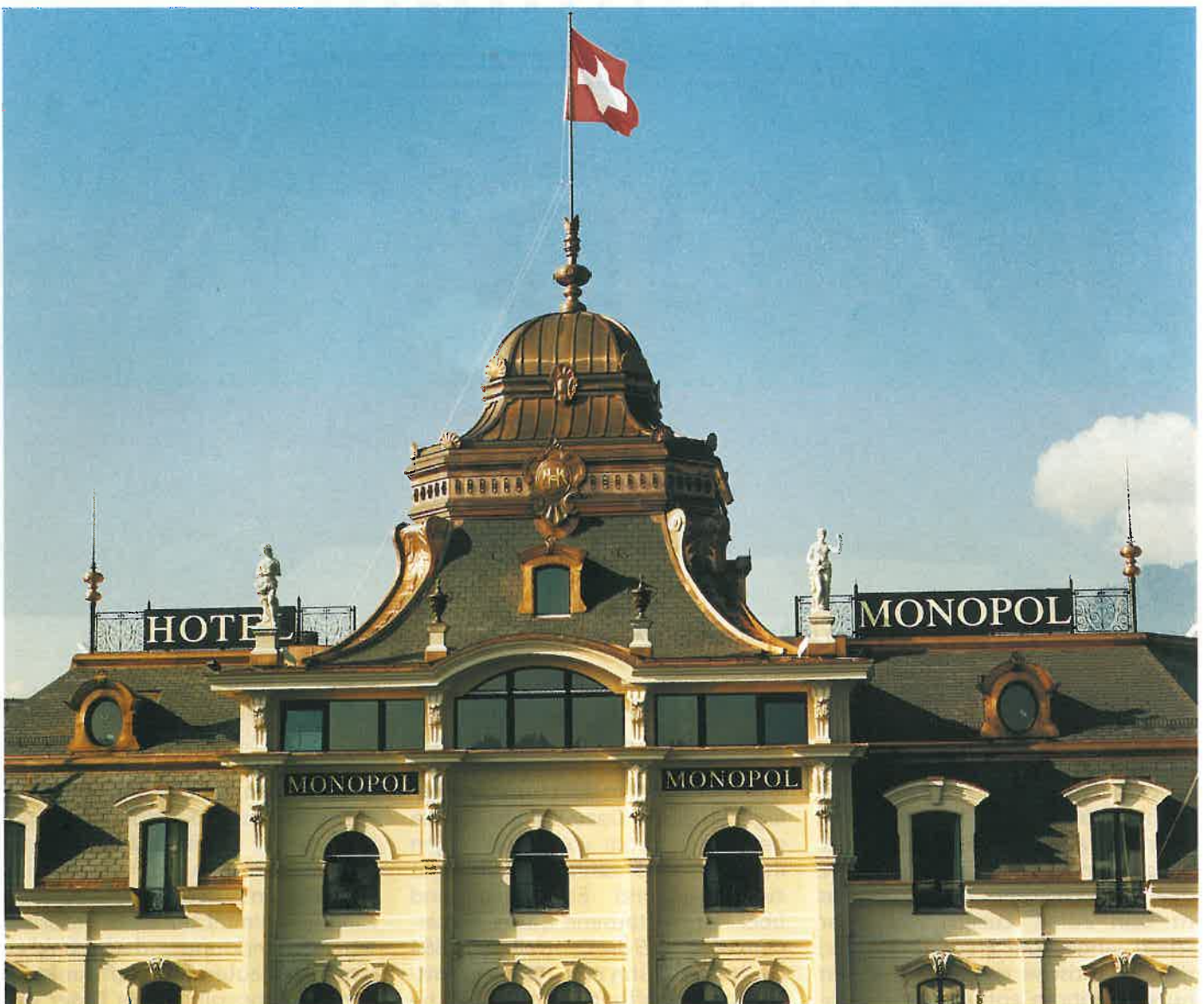
Ansicht der neuen Kuppel.
